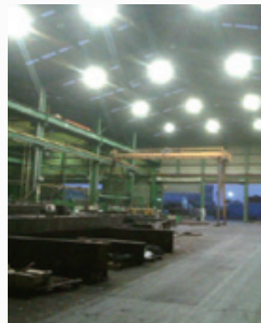
取替後 Highbay 185W 12 台
