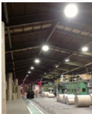
取替後 Highbay170W 13 台
